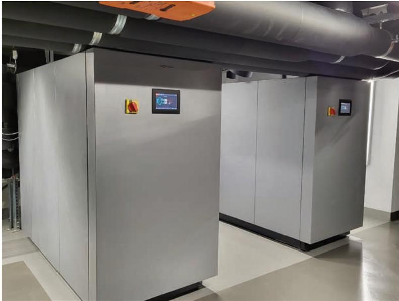
Die beiden umschaltbaren Wärmepumpen/Kältemaschinen haben eine Heizleistung von insgesamt rund 350 kW und eine Kälteleistung von 400 kW. Sie versorgen insgesamt fünf thermische Speicher.
