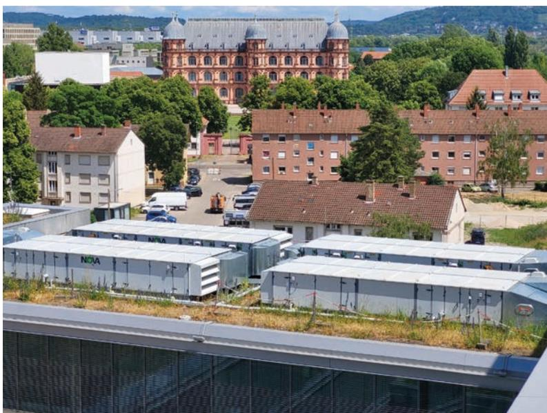
**Aus optischen Gründen zur Verringerung der Aufbauhöhe wurden bei den auf zwei Flachdächern aufgestellten acht RLT-Geräten die Zuluft- und Abluftteile nebeneinander ausgeführt.**
