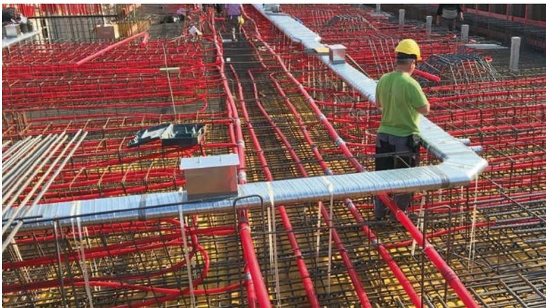
Um eine möglichst geringen Installationshöhe zu erreichen, wurden alle Luftleitungen mit platzsparenden, feuerverzinkten Ovalrohren ausgeführt und in die Betondecken eingegossen. [Abb. © M+A Hagen GmbH]
