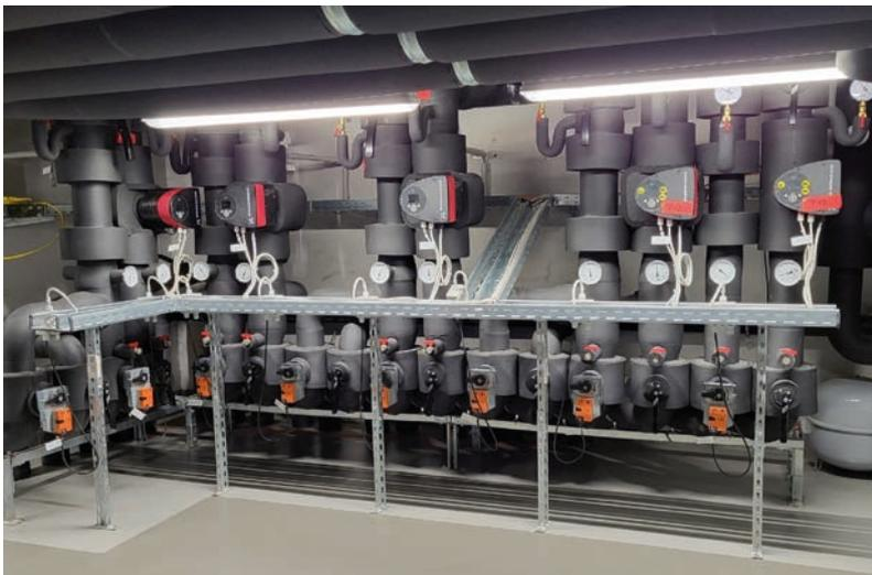
Die Pumpen-Verteilstation zur Be- und Entladung der Heiz- und Kühl-Betonspeicher
